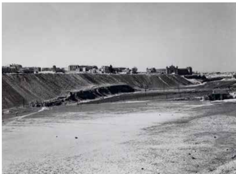
Talud de Ventas. Arroyo Abroñigal y Fuente del Berro, 1940. Centro de Documentación de Medio Ambiente y Ordenación del Territorio
